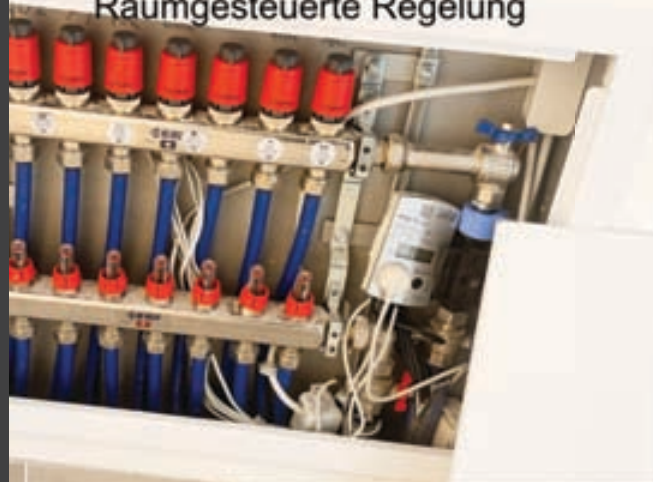
Heizkreisverteiler mit Fernablesung Raumgesteuerte Regelung
